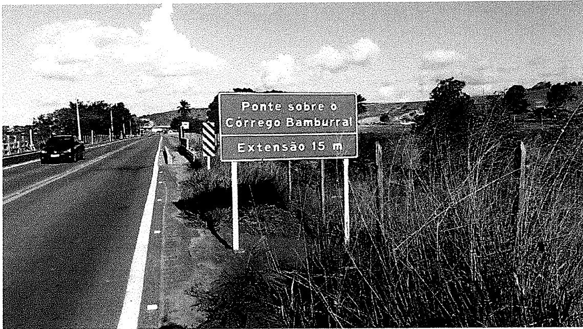
Figura 1 – Ponte sobre o Córrego Bamburral
